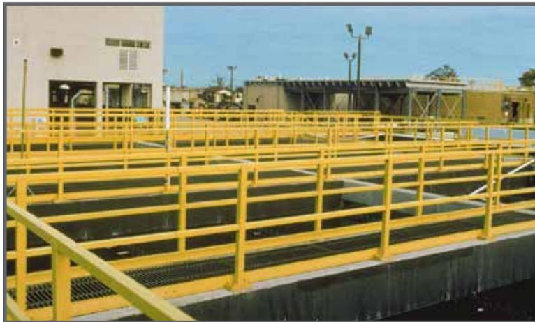
*Une main courante en tube carré fabriquée à partir de composants Dynaform démontre sa durabilité dans le milieu corrosif de cette usine de traitement des eaux usées.*
