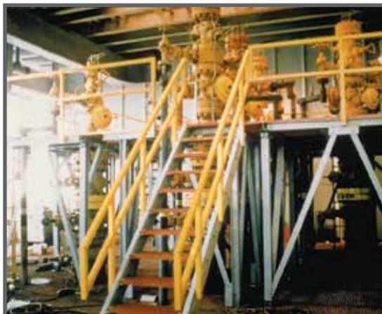
*La structure d'appui et les garde-corps en tube carré Dynaform assurent un niveau élevé de résistance à la corrosion pour cette plateforme offshore.*
